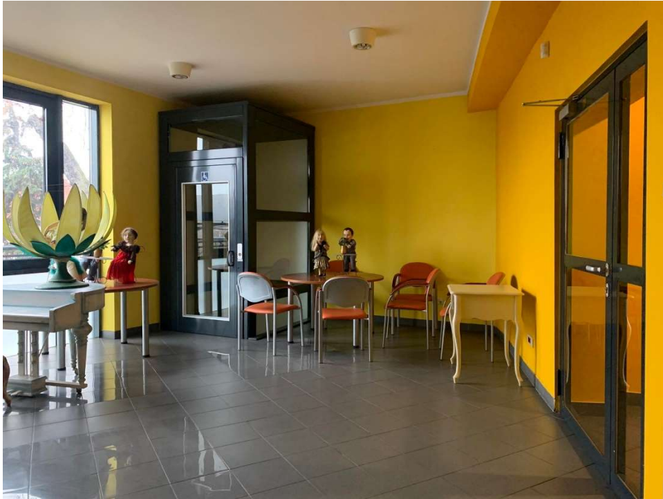
Zdj.7 Winda dla niepełnosprawnych powinna być zawsze dostępna i nie zastawiona innymi obiektami.
