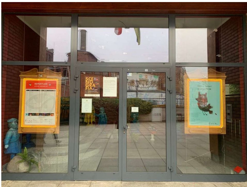
Zdj.9 Brak informacji dla osób niepełnosprawnych; klamka do drzwi powinna być w formie poziomego uchwytu
